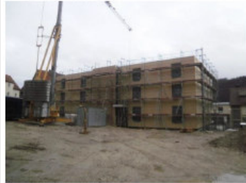
Neubau Hukelturenstraße 11 im Bau
