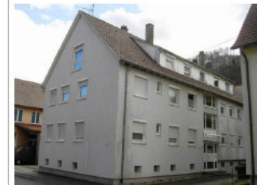
Baschianstraße 48 vor der Sanierung
