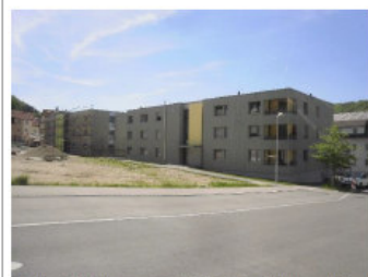
Neubau Hukelturenstraße 11 im Bau (links) und Friedrich-Haux-Straße 42 (rechts)
