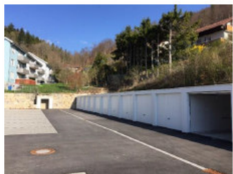
Neue Garagenanlage Im Raidental 80/1
