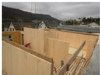
Neubau Hukelturenstraße 11 im Bau
