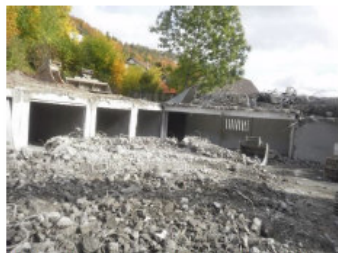
Rückbau der Tiefgaragenanlage Im Raidental 80/1
