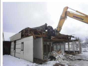
Rückbau des Flachdachanbaus
