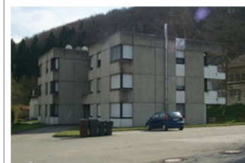
Das Gebäude Mühlstraße 91 mit der maroden vorgehängten Betonfassade vor der Modernisierung.
