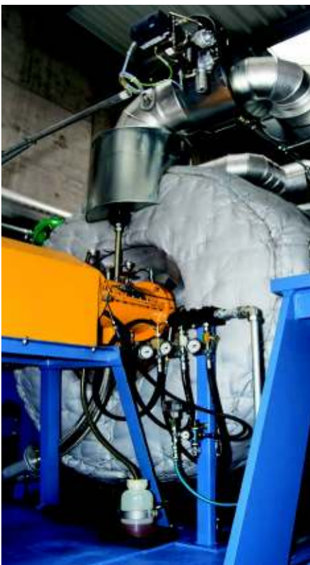
Bild oben Thermoölkessel
