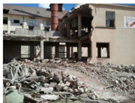
... während des Rückbaus
