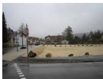
... nach dem Rückbau
