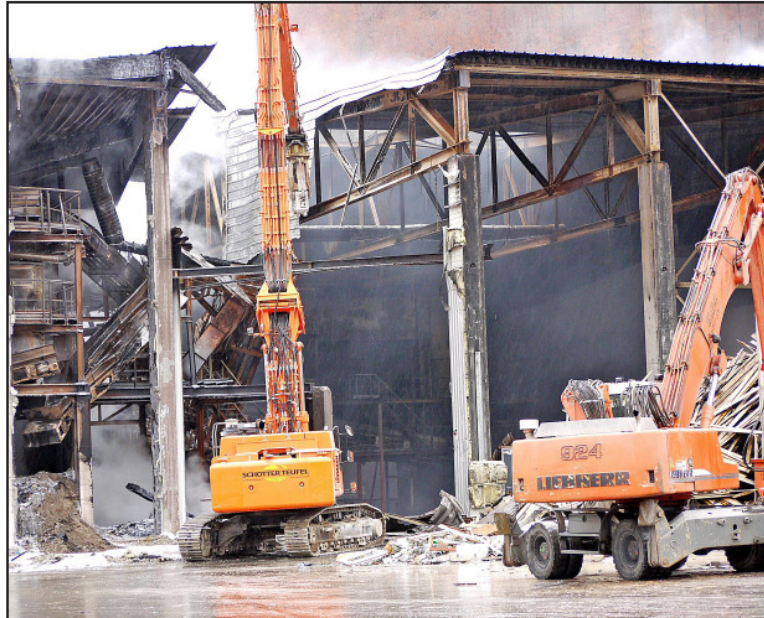
Sisyphosarbeit: In der Brandruine der neuen Halle der Firma Korn hat das große Aufräumen begonnen, das noch eine Woche dauern dürfte. Rund 800 Tonnen verbrannter Wertstoffe müssen auseinandergezogen, abgelöscht und entsorgt werden. Fotos: Eyrych
